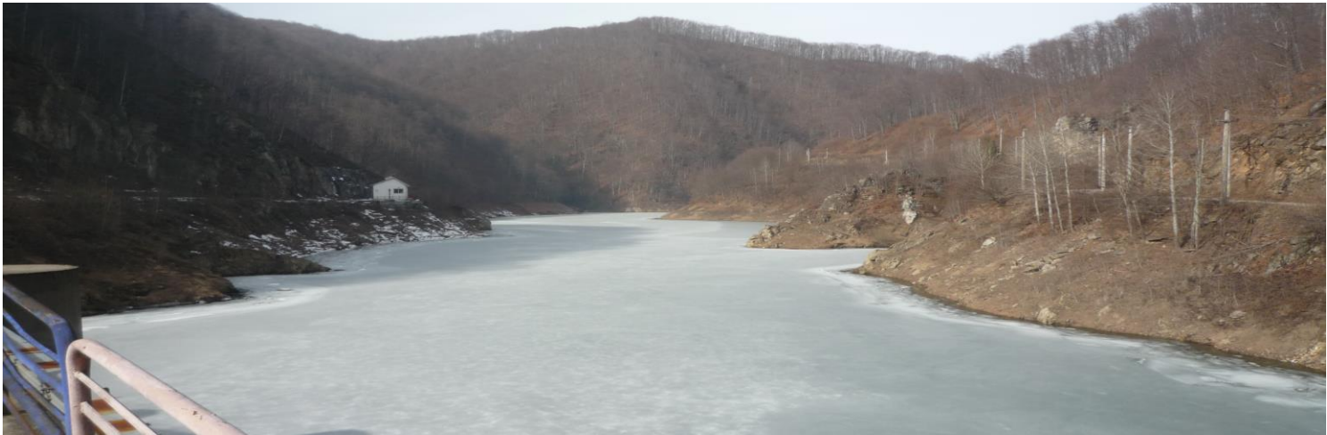
Barajul, acumulara și camera puțului derivației Clocotiș-Tismana
